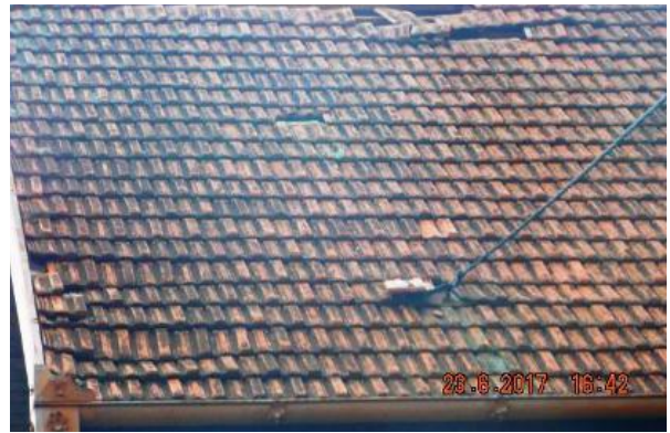
2. Šteta na krovu od oluje – foto iz blizine (zumirano)
