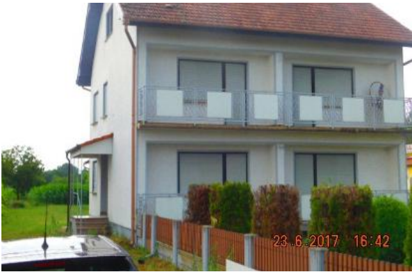
1. Šteta na krovu od oluje – foto iz daljine
