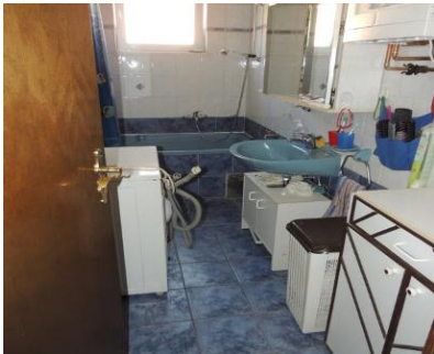
1. Puknuće cijevi u kupaoni
